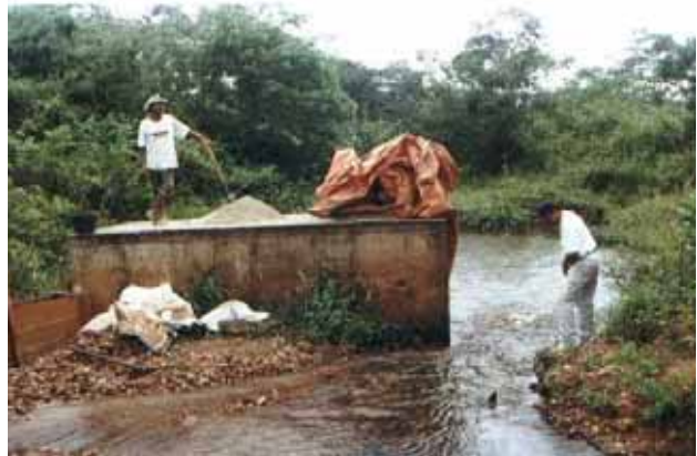
Figura 9.14. Vista de la ubicación de la cámara de válvulas y de la pérdidas de caudal por el pie del talud de la presa
