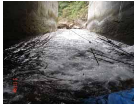
Figura 9.12. Vista de los daños sufridos por la losa de fondo del desagüe de fondo después de ocurrido el fenómeno
