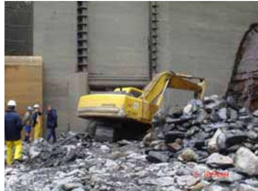
Figura 9.10. Vista de la magnitud y la cantidad de sedimentos que llegaron hasta el desagüe de fondo
