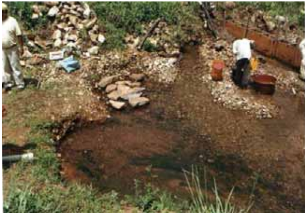
Figura 9.13. Vista de las filtraciones al pie del talud seco de la presa
