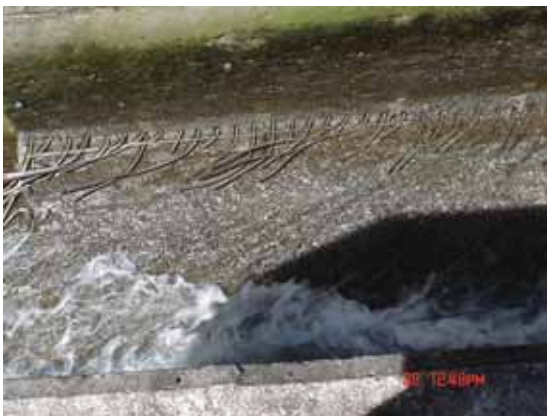
Figura 9.11. Vista de los daños sufridos por la losa de fondo del desagüe de fondo después de ocurrido el fenómeno
