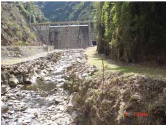
Figura 9.13. Vista del canal de salida del aliviadero parcialmente destruido
